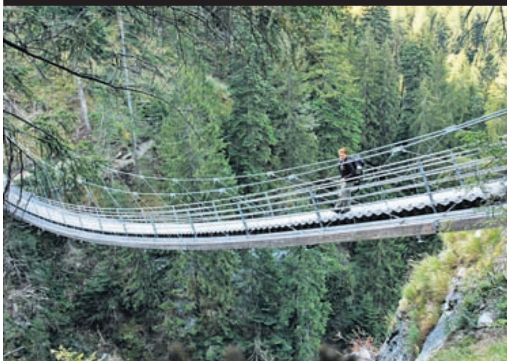
Schwindelerregend. Eine Hängebrücke führt hoch über das Traversinatobel.
